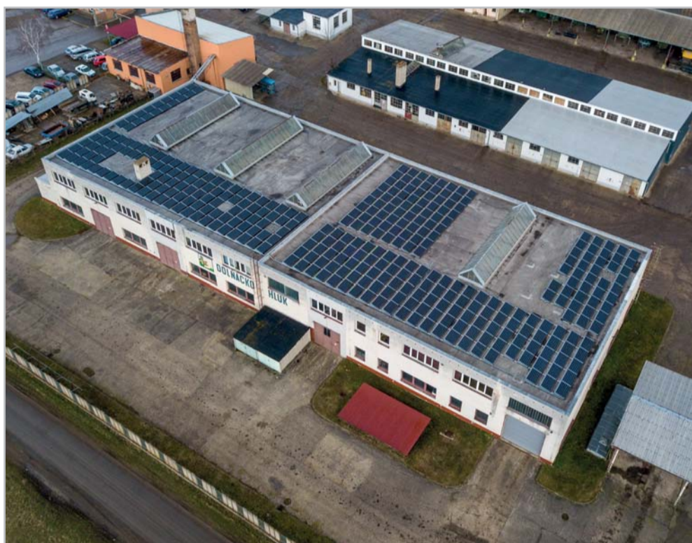
Fotovoltaický systém na ploché střeše nepotřebuje kotvení a nenaruší tak střešní plášť Foto archiv firmy
