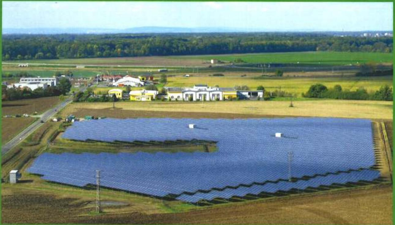
Fotovoltaická elektrárna Kroměříž – Bilany; instalovaný výkon: 4,5 MW, celková investice 360 mil. Kč
