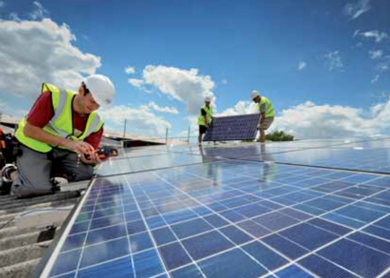
Zahájení výstavby fotovoltaických elektráren (2009)
