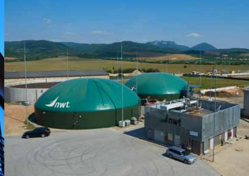
Bioplynová stanice Kameničany (SK)
