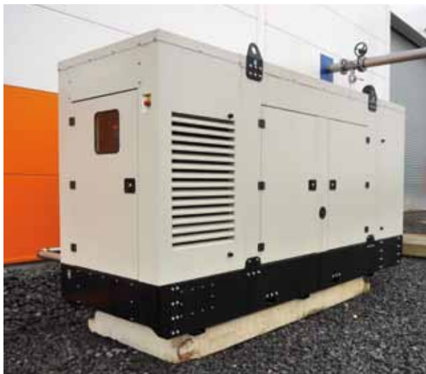
Kogenerační jednotka na výrobu elektrické energie
